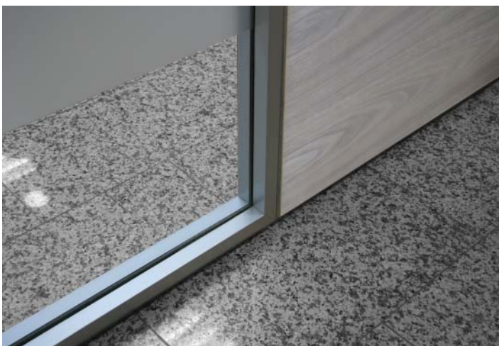
Glazed-blind joint. Unión ciego-vidrio. Verbindung undurchsichtig-Glas.
